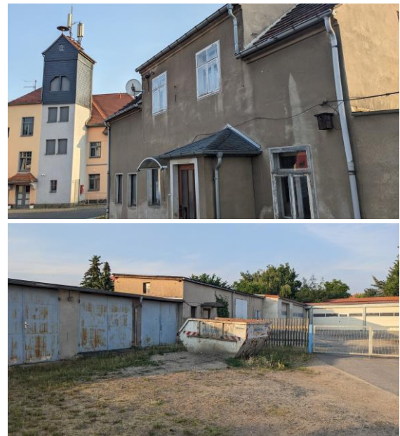
Bauhofstandort mit Sozialgebäude (o. r. im Bild und Nebengebäuden (unten))
