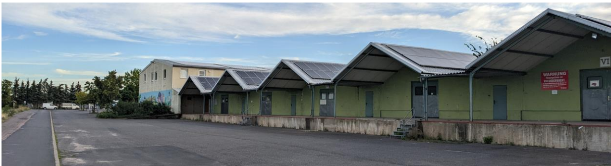
Ehrlichtweg, großflächige Photovoltaikanlage auf Gewerbestandort
